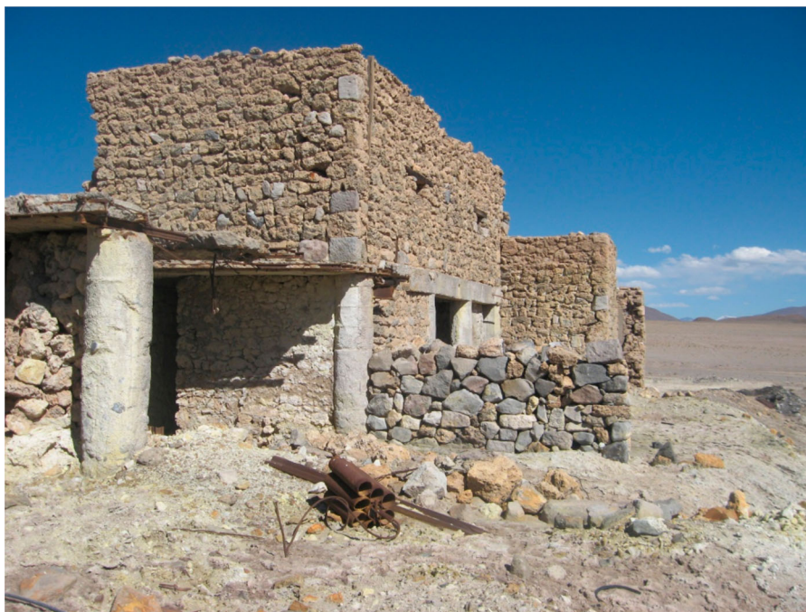
Figure 10. Structure surrounding the autoclaves at the Buenaventura site. © Proyecto Arqueológico Alto Cielo.
