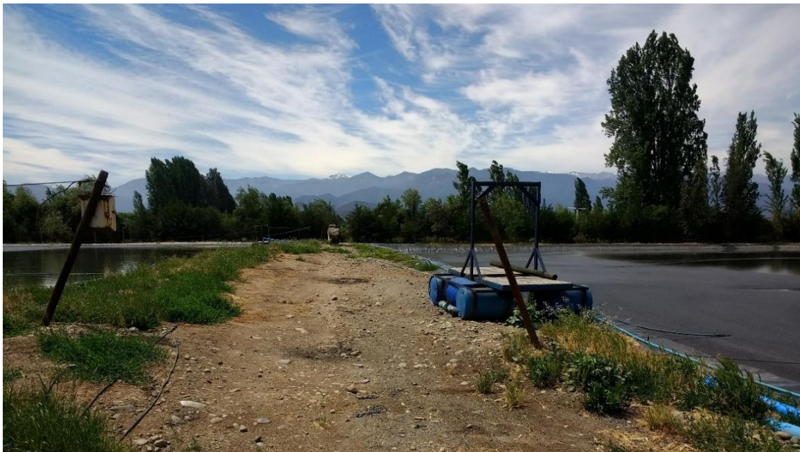
Figura 11. Tratamiento secundario del purín lagunas N°1 (derecha) y N°2 (izquierda). (Fuente: Elaboración propia).
