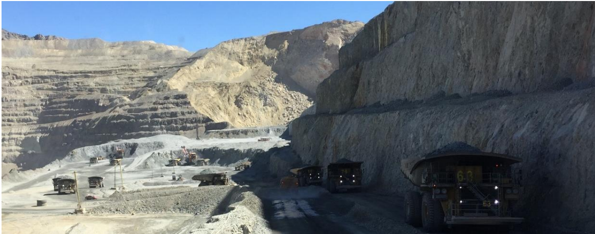
Ilustración 3: Derrame en pista forma una cola de 7 camiones (OPNP). Fotografía propia.
