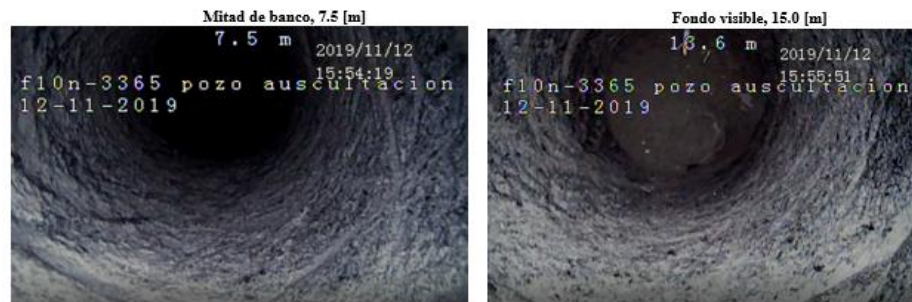
Ilustración 100: Auscultación de pozo, tramo inferior del pozo (Fuente Propia).
