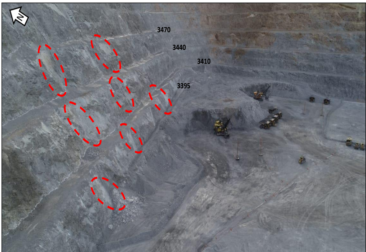
Ilustración 49: Condición estructural actual de F10N, Mina Los Pelambres (Fuente Propia).
