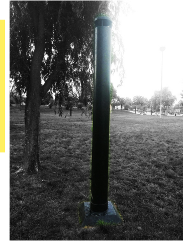
Imagen 29. Chimeneas. Fuente: Elaboración propia Imagen
