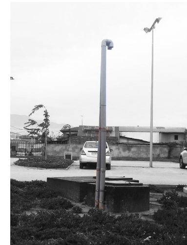
Imagen 30. Chimeneas. Fuente: Elaboración propia Imagen
