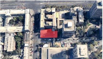
Imagen 35. Superficie terreno 2 Fuente. Google Earth
