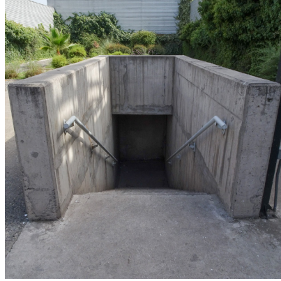
fig. Izquierda 1 y 2 Acceso subterráneo terreno Norte Oficina AA
