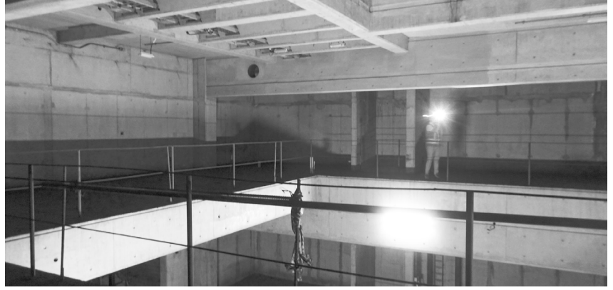
fig. Derecha e Inferior Imagen interior subterráneo desde nivel -1 Oficina AA
