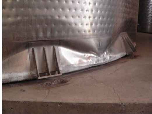
Figura 2.16: Falla Sistema de Anclaje. [11]
