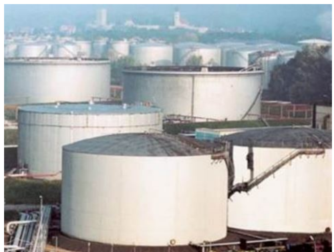
b Estanques de acero
