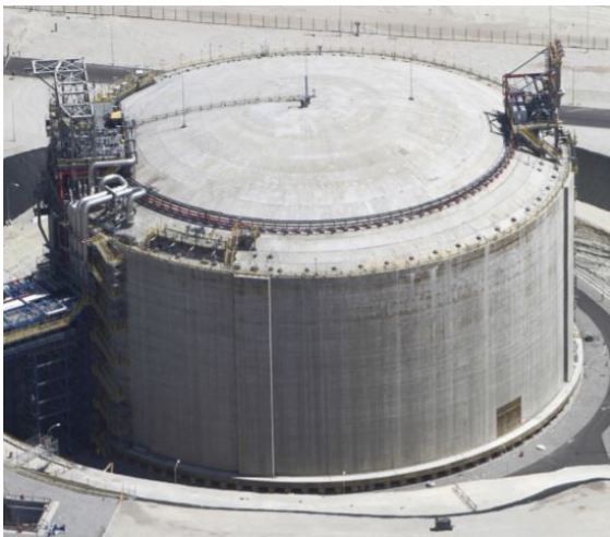
a Estanque de Hormigón Armado, Mejillones, Chile. [23]
