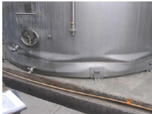
Figura 2.14: Pandeo Local (Punta de Diamante).[11]
