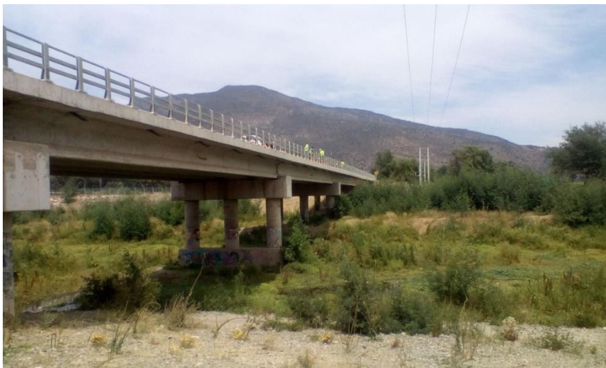
Figura 4.1 Puente Águila Norte, vista sur poniente (Grand, 2019).
