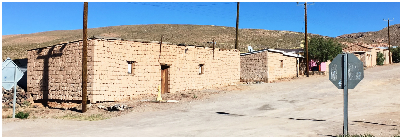
Figura 69. Vivienda construida con técnicas y materiales vernaculares ubicada en la calle 21 de mayo. Fuente: E.P.
