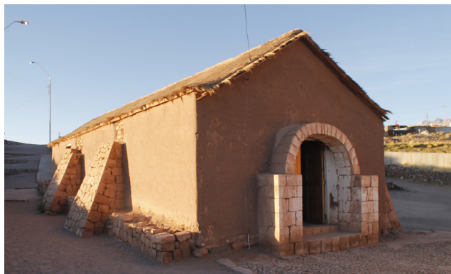
Figura 61. Fotografías de la Iglesia antigua de Socaire. Fuente: Elaboración propia.
