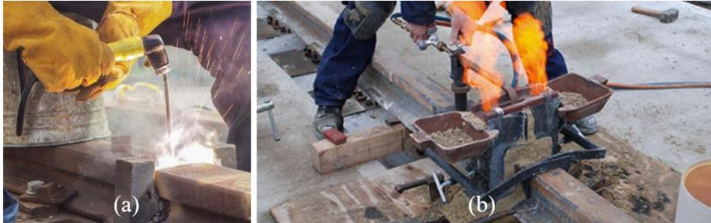
Figura 8.4: (a) Soldadura de arco. (b) Soldadura aluminotérmica.
