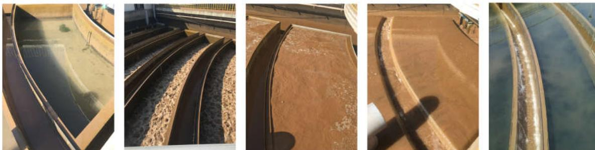
*Figura 5.20. Serie fotográfica del retrolavado en filtro Multicrete II.*
