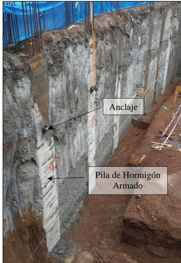
**Figura 2.7 Pilas de entibación con un nivel de anclaje, edificio Premio Nobel (SUBT SpA, 2017).**
