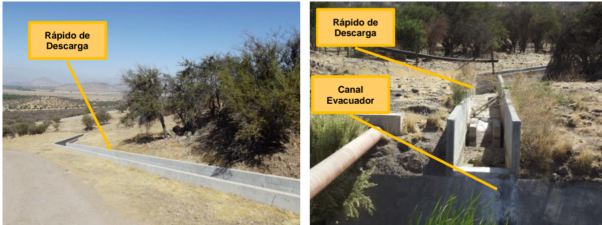
Fotografía 5-7: Rápido de Descarga a Canal Evacuador
