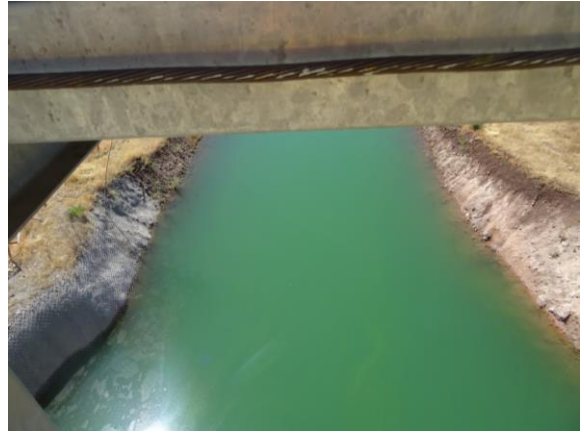
Canal de aproximación torre de Captación
