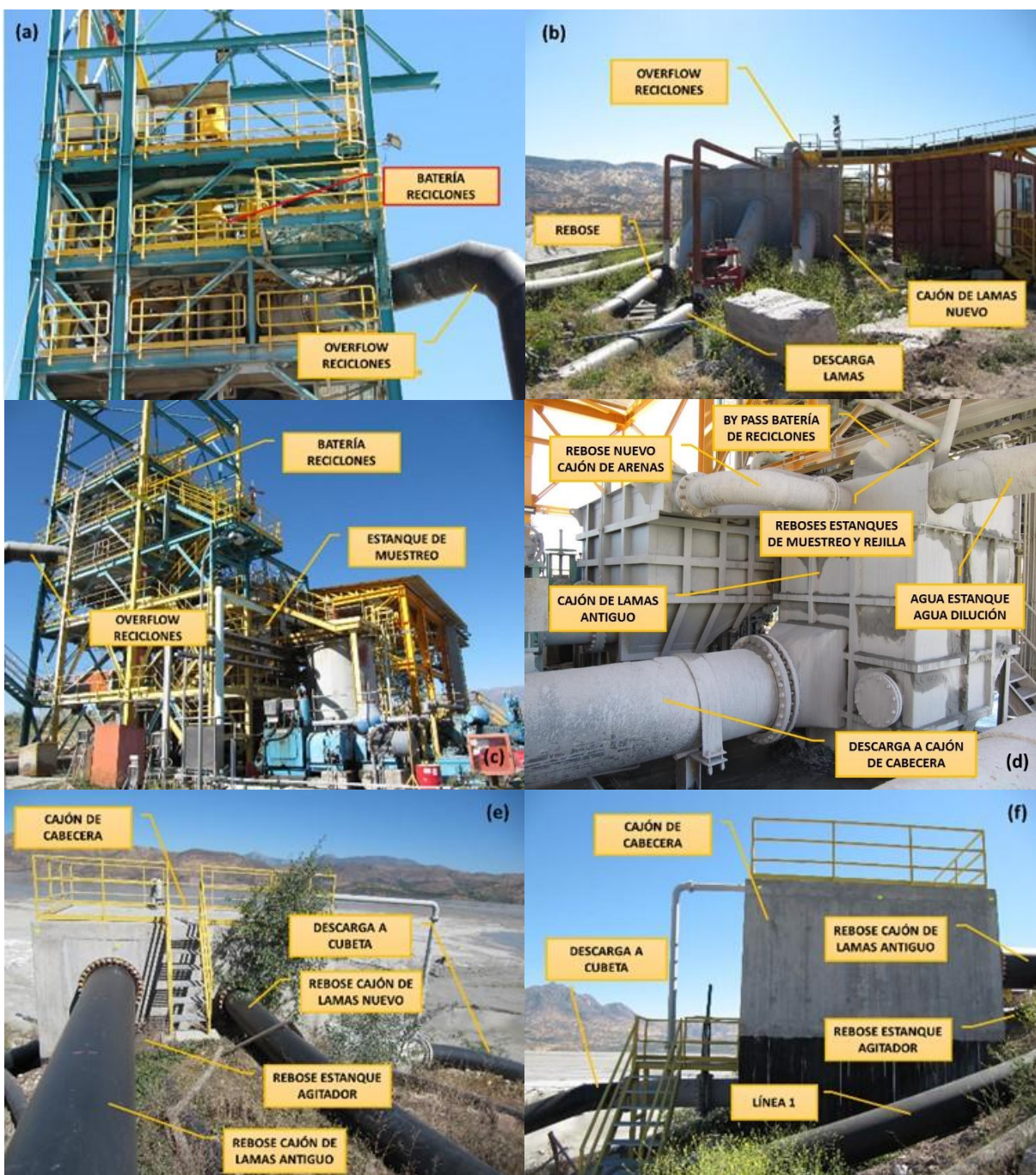
Descripción: (a) Bateria reciclones. (b) Cajón de lamas nuevo. (c) Estanque de muestreo. (d) Cajón de lamas antiguo. (e) y (f) Cajón de Cabecera.
