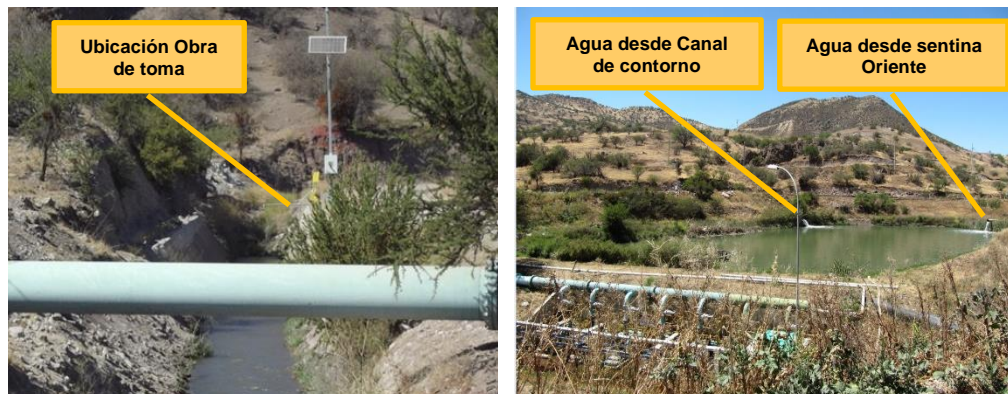
Fotografía 5-5: Obra de toma Piscina agua de dilución
