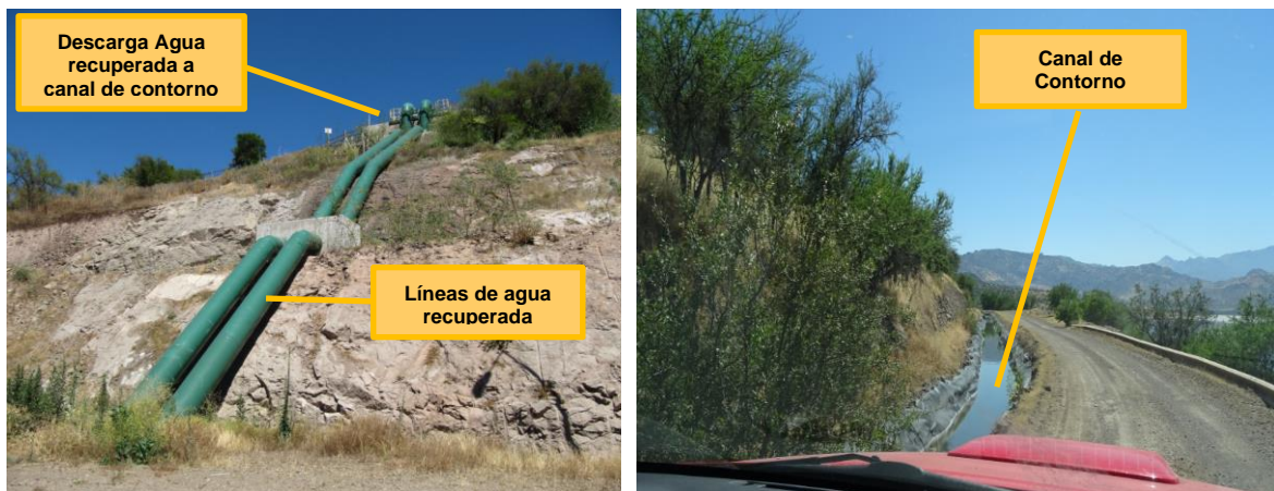
Fotografía 5-3: Descarga de Agua Recuperada y Canal de Contorno
