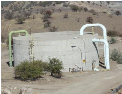
Bomba de impulsión agua de lavado
