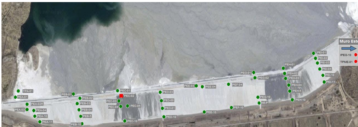
Fotografía 4-7: Piezómetros en Muro Principal
