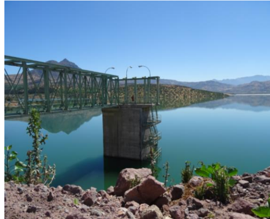
Torre de Evacuación
