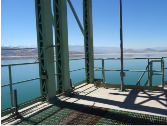
Sobre Plataforma Torre Evacuación / Laguna de Agua Clara
