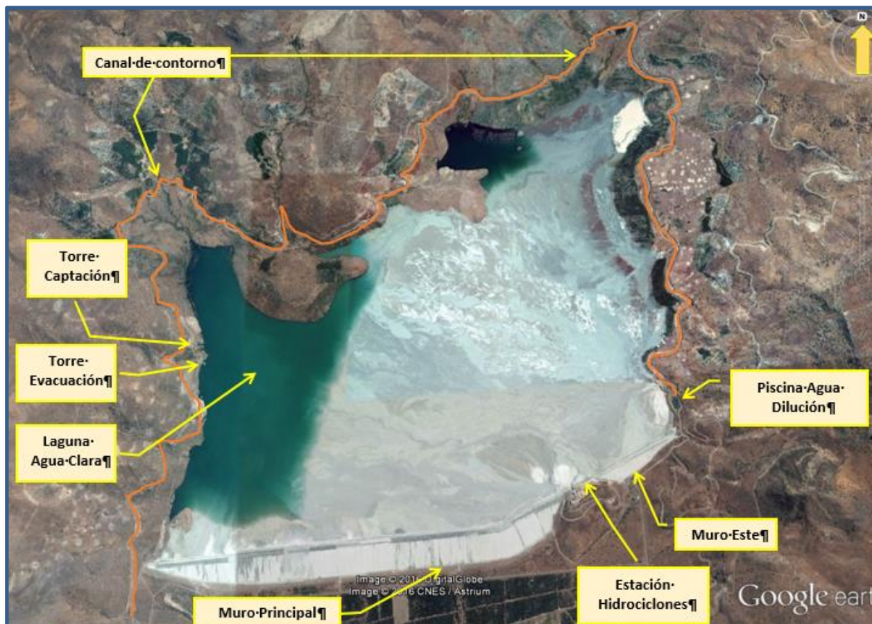
Figura 5-3: Principales Instalaciones para el Manejo de Aguas del Tranque
