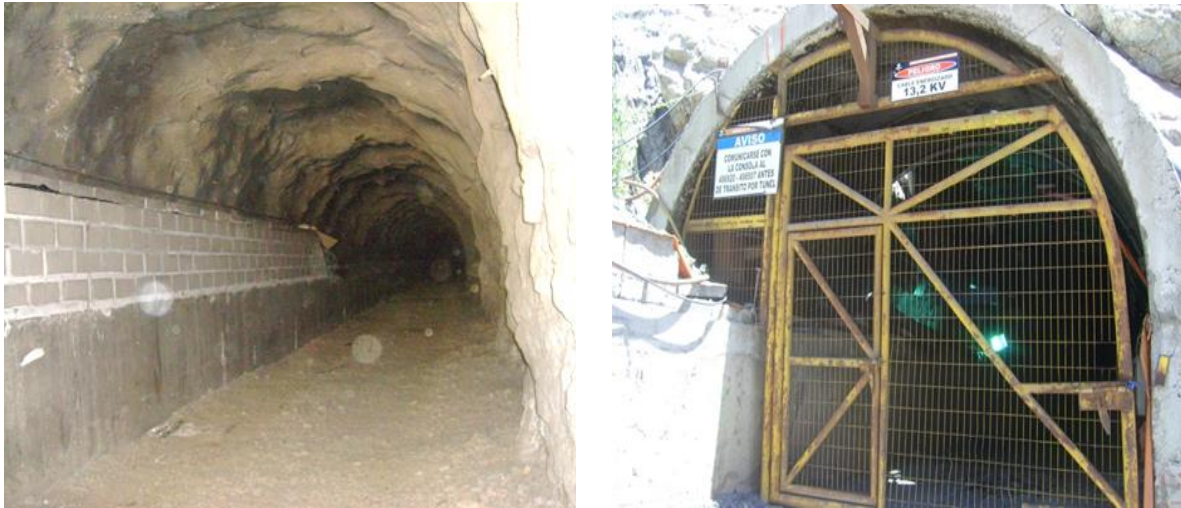
Ingreso Túnel Menor
