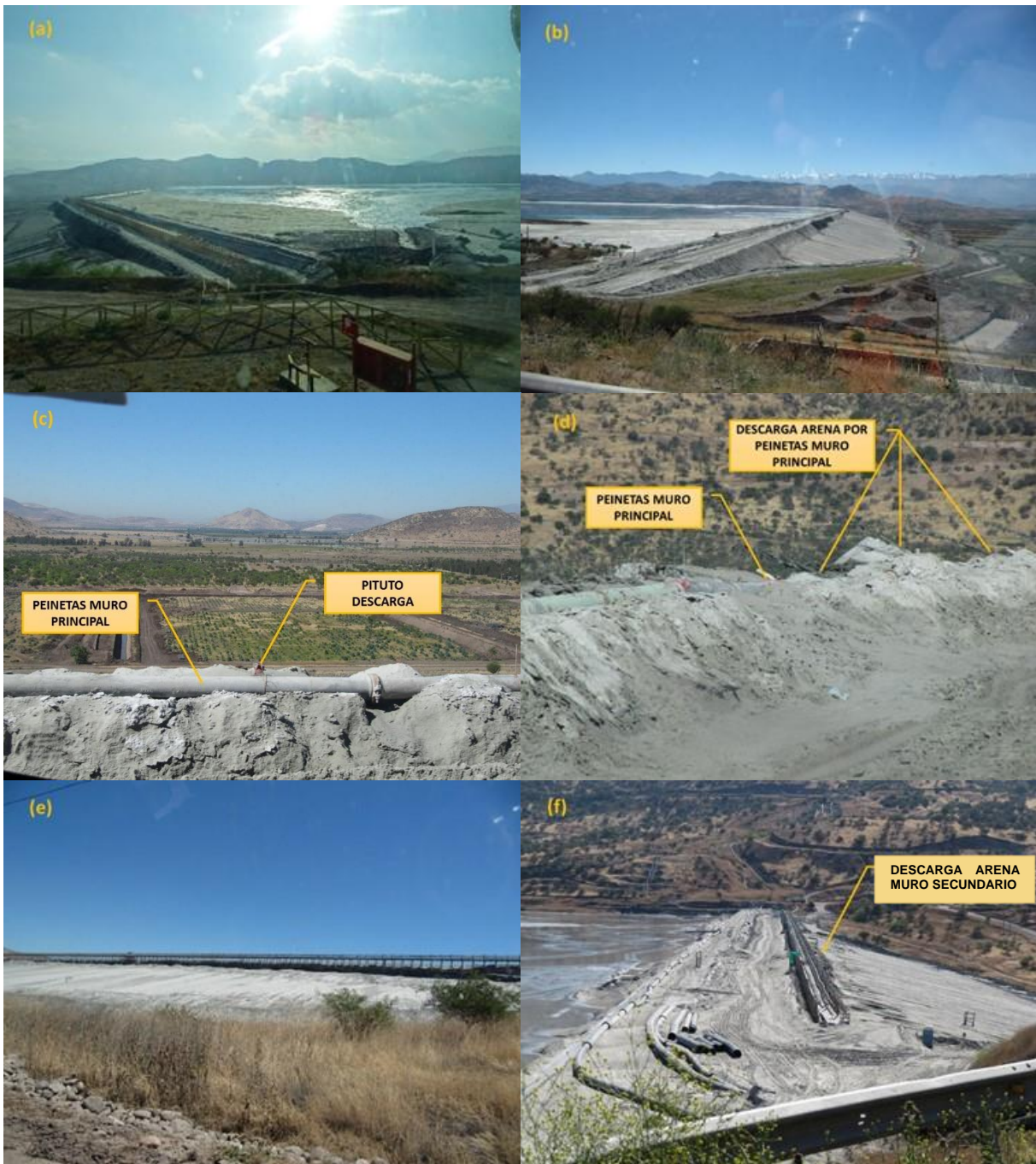
Fotografía 4-6: Vistas Construcción Muro Principal y Muro Secundario
