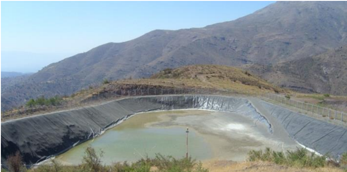
Fotografía 3-5: Embalse de Seguridad N°1
