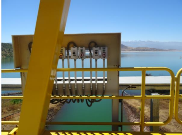
Canal de aproximación torre de Captación
