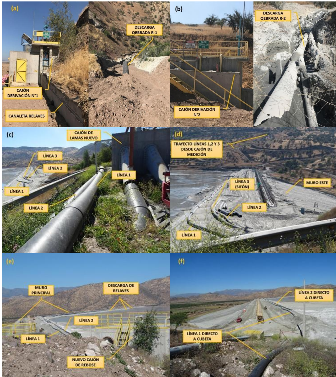
Fotografía 4-2: Sistema de Conducción de Relaves hacia la Cubeta
