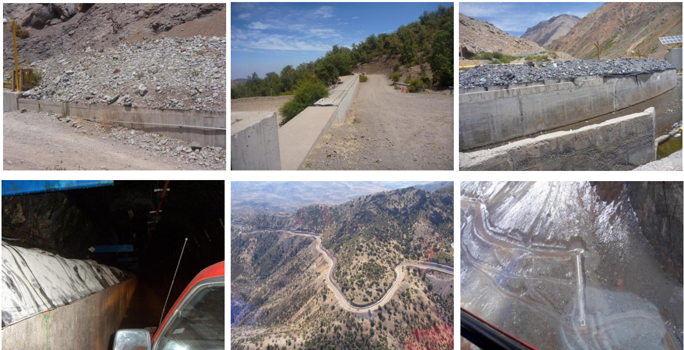
Fotografía 3-1: Canaleta del STR
