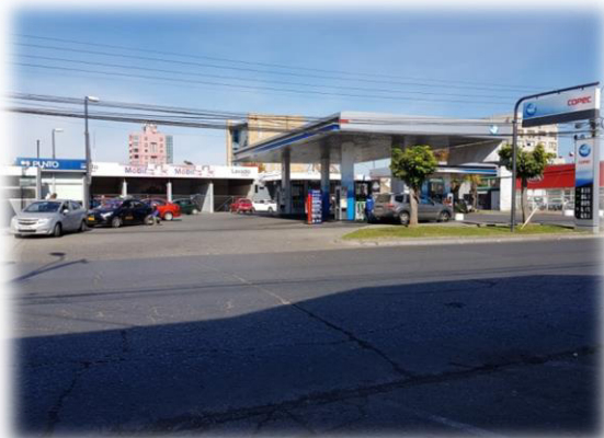
SERVICIOS DE CONBUSTIBLE AL COSTADO DEL TERRENO
