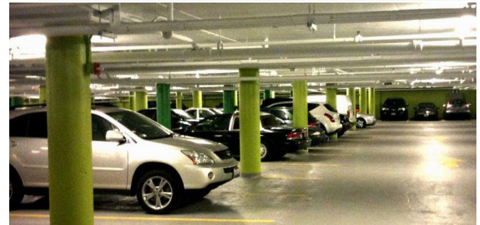
Estacionamiento de edificio del centro de Concepción
