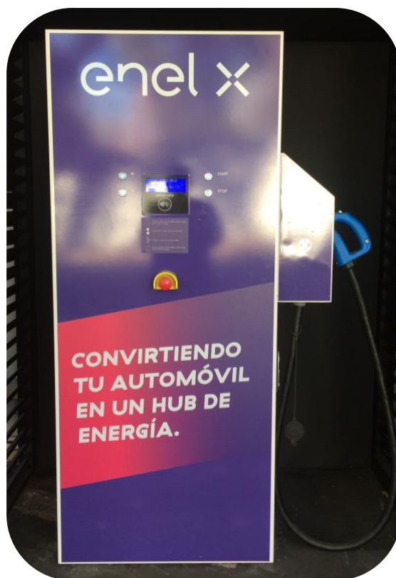
Figura 2.2: Infraestructura de carga bidireccional V2G.
