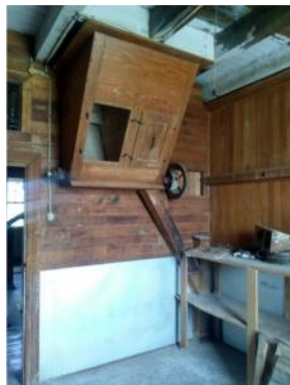
Fig.76- Contenedor de extractor Elaborada por el autor
