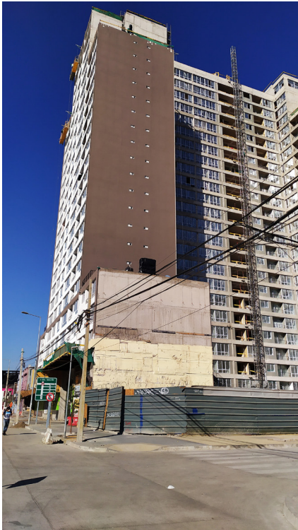
Fig. 30 Torre en construcción (mayo 2020) de 24 pisos frente al monumento Ex cervecería de Andrés Evner
