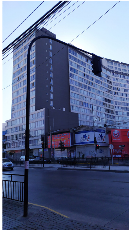
Fig. 31 Torre de 20 pisos en Av. Independencia
