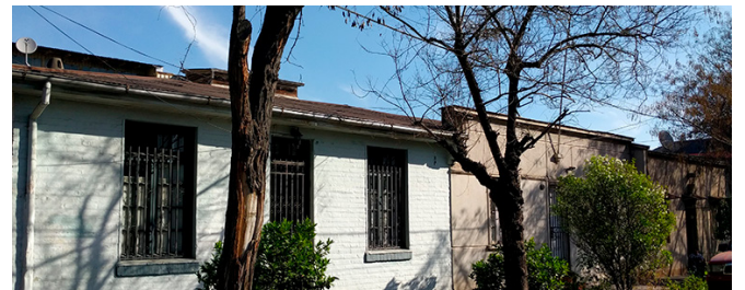
Fig. 05 Viviendas calle Sevilla, Independencia, construidas con la Ley de habitaciones baratas. Fuente: https://www.independenciacultural.cl/2017/04/10/poblacion-la-universal/
