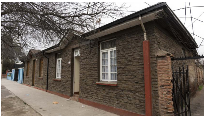
Fig. 29 Vivienda Población Manuel Montt (Zona típica)
