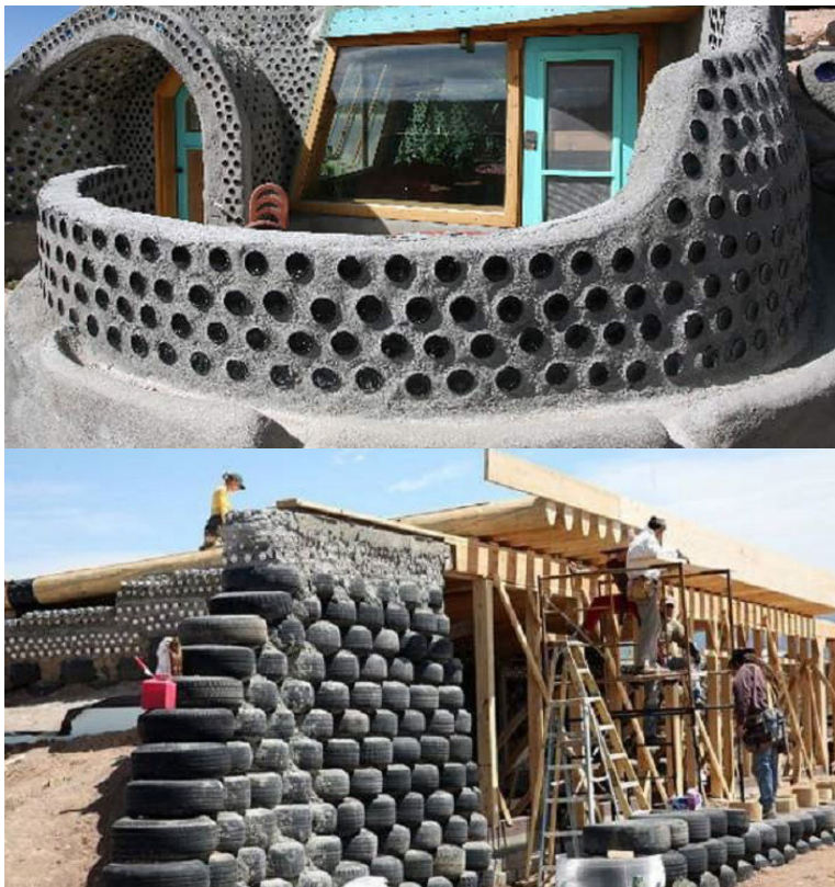
Ejemplos de construcción con materiales reciclables (Fuente: planos-casas.com / inarquia.es)
