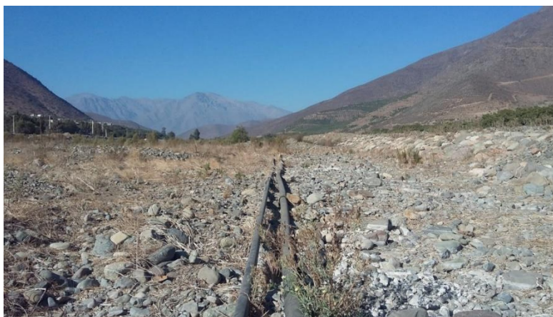
Figura 4: Fotografía de la aducción 1 en cauce del Río Petorca, sector pueblo de Petorca
