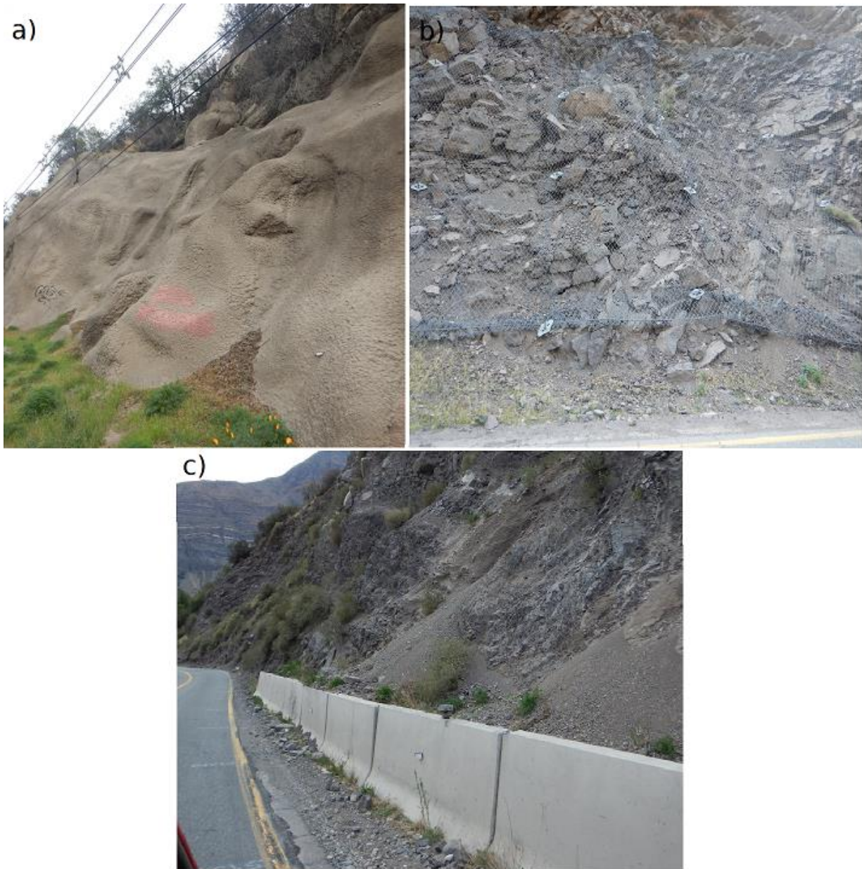
Figura 68: Medidas para mitigar el peligro de caídas de rocas en la Ruta G-25. a) Hormigón proyectado o shotcrete, b) Malla estabilizadora y c) Barreras.
