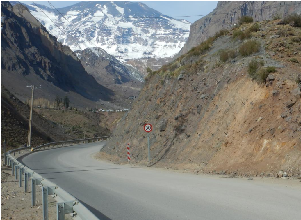
Figura 54: Talud fortificado completamente, en el kilómetro 75 aproximadamente.
