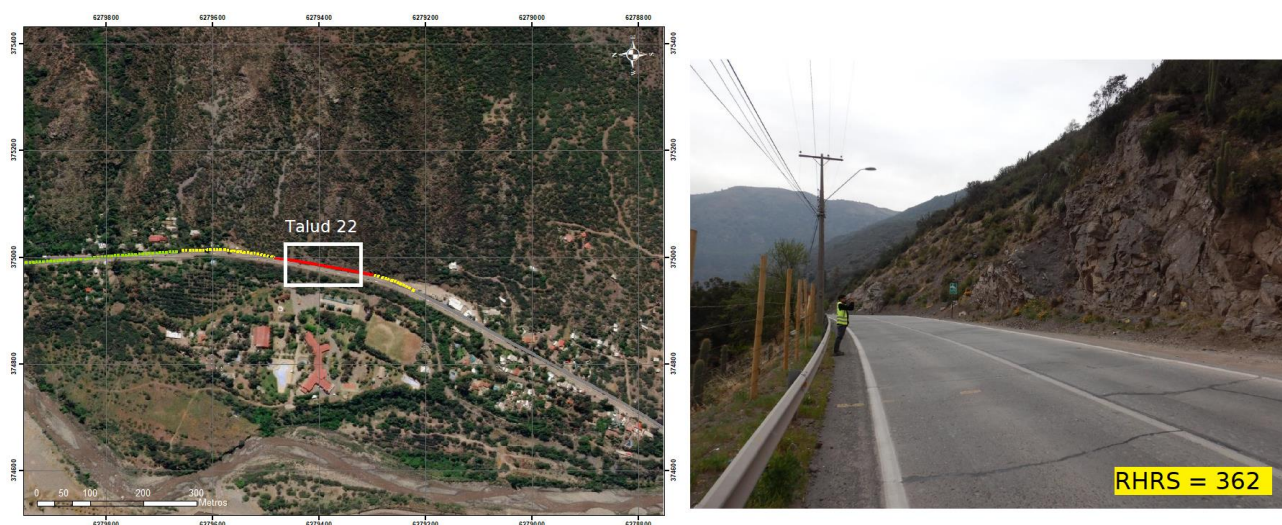
Figura 72: Talud 22 calificado mediante el RHRS.
