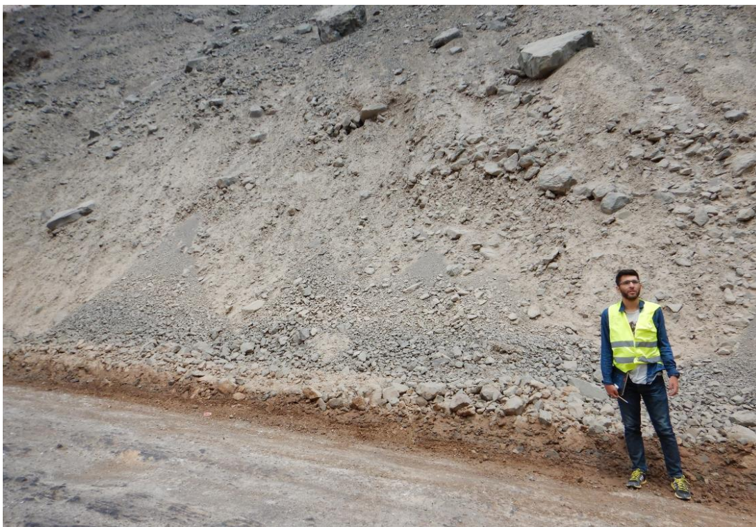
Figura 22: Corte transversal a depósito taluvial a la altura del kilómetro 80 aproximadamente.
