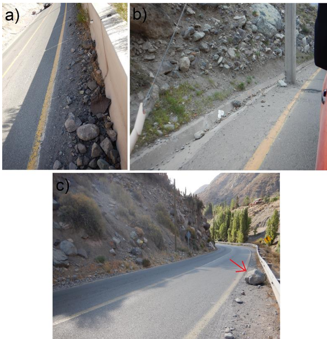
Figura 66: Bloques identificados en Ruta G-25. a) numerosos bloques que reposan en berma contraria al talud que se identifica como la fuente, kilómetro 52 aproximadamente, b) bloques en berma a orillas del camino, kilómetro 57 aproximadamente, c) bloque de gran tamaño en berma contraria al talud clásico, kilómetro 58 aproximadamente.
