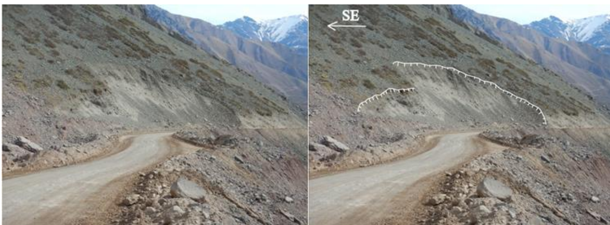
Figura 35: Escarpe observado en depósitos taluviales en el kilómetro 79 aproximadamente. Se observa que actualmente se encuentra activo (CoorE:404384; CoorN:6256772; WGS 84 Zona 19S)
