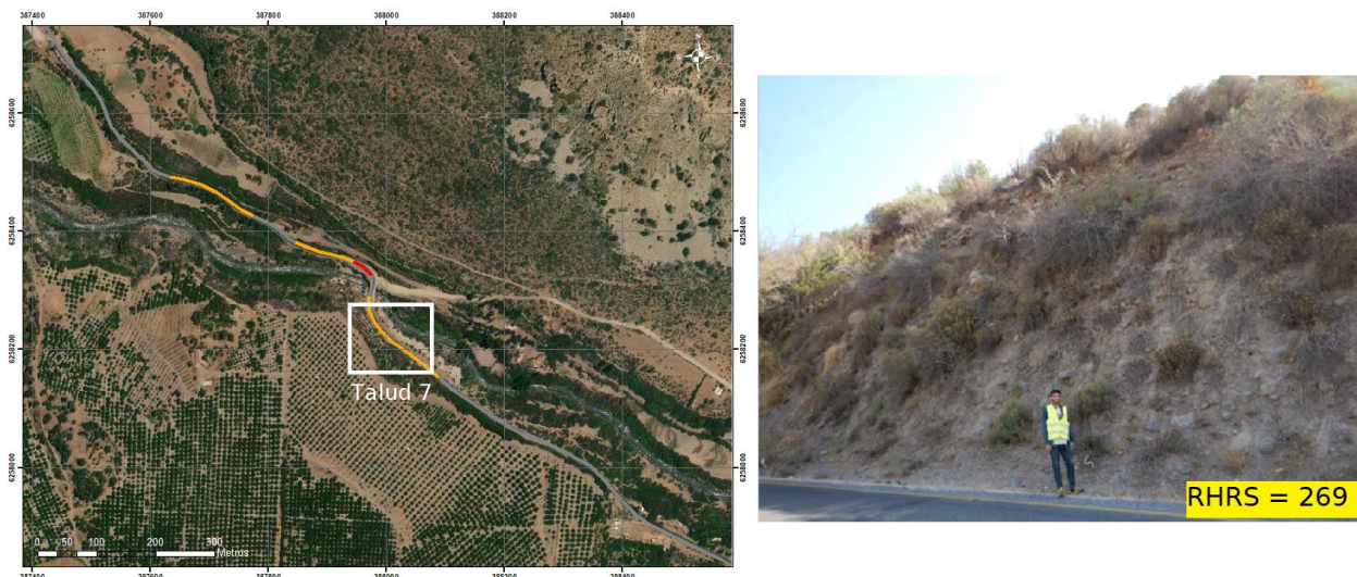
Figura 71: Talud 7 calificado mediante RHRS.
