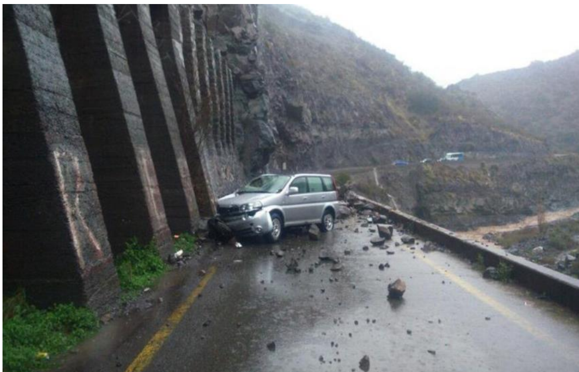
Figura 73: Caída de rocas en sector Túnel El Tinoco. Fuente: Municipalidad de San José de Maipo (2015).
