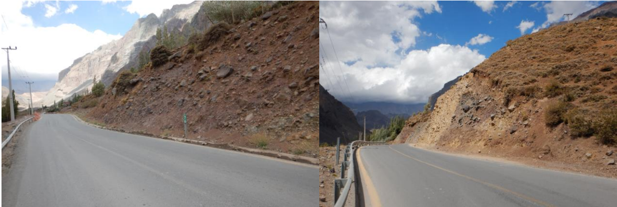
Figura 52: Taludes de depósitos no consolidados ubicados a lo largo de la Ruta G-25.
