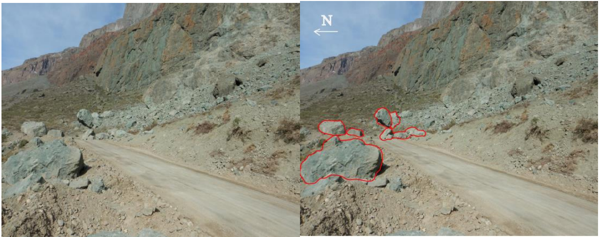
Figura 37: Bloques métricos a orillas de la ruta, en el kilómetro 78 aproximadamente. Misma litología que pared rocosa a al sur del camino. (CoorE:403467; CoorN:6256403; WGS 84 Zona 19S).
