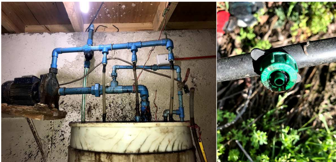
Figura 10. Acumulación de residuos por uso de ácidos húmicos. A la izquierda, residuos en sistema de inyección de fertilizantes; a la derecha, acumulación de residuos en emisores.
