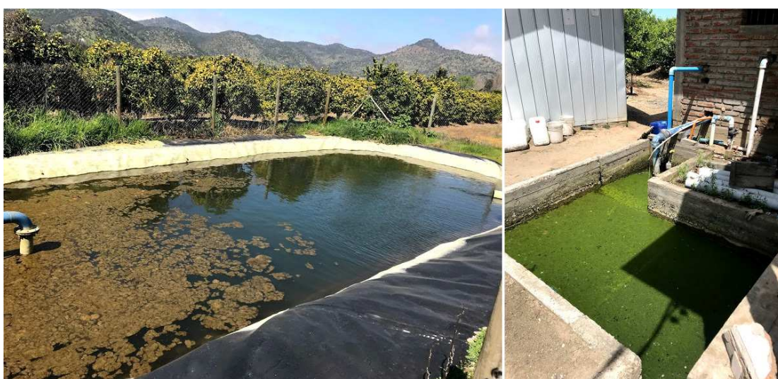
Figura 11. Presencia de algas y bacterias en acumuladores de agua de riego.
