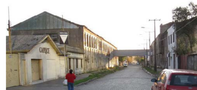
(fig.51) Acceso al barrio Aurora caracterizado por la fábrica.
