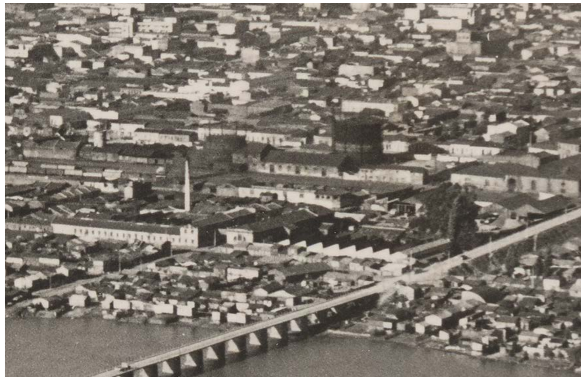
(fig.03) Vista aérea, Fábrica de Paños Bio Bío
