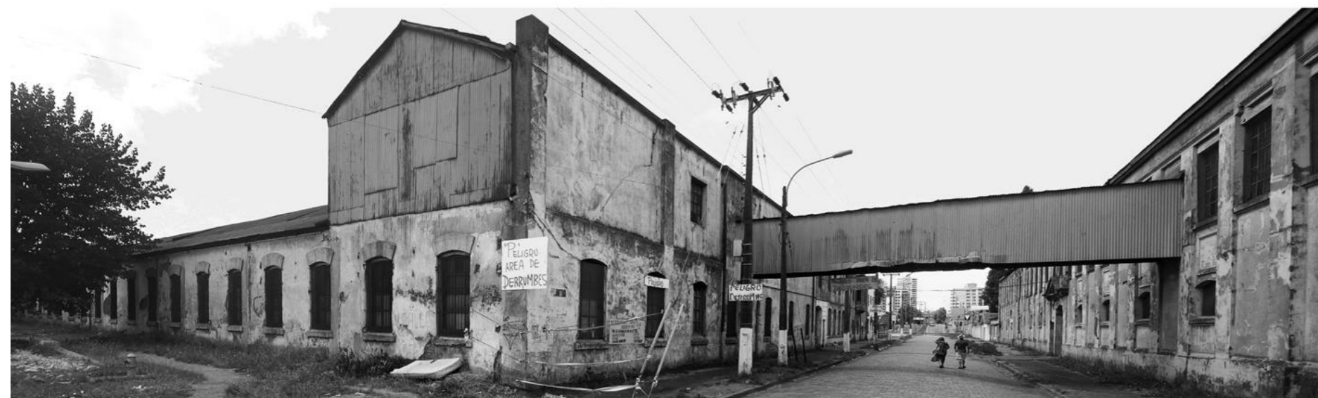
(fig.46) Abandono de la fábrica, situación año 2015.
