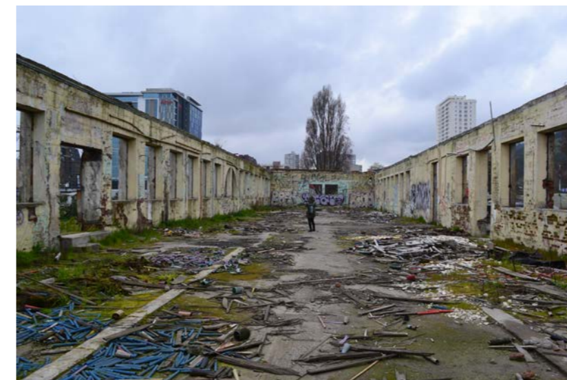
(fig.48) Situación actual espacios interiores, nivel +1 Pabellón Sur (ED01).
