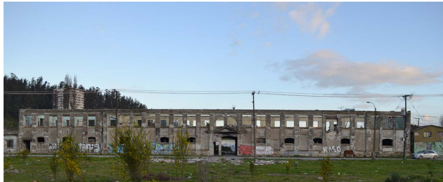
(fig.35) Restos Ex - Fábrica de Paños Bio Bío, Pabellón Sur
