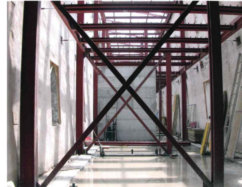
(fig.90) Referente: Villa Contarini , Foresterie vecchie. Intervención de consolidación estructural de la preexistencia.
