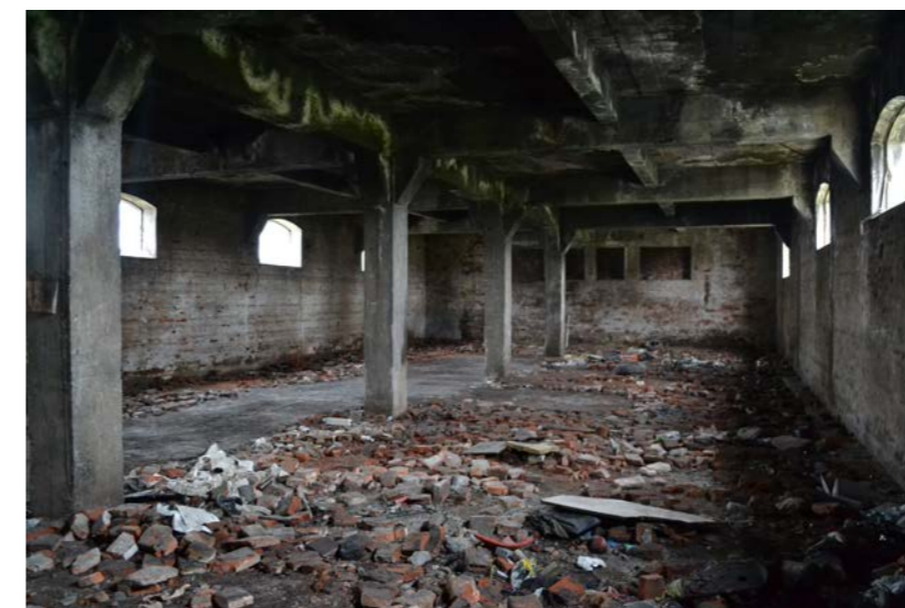
(fig.47) Situación actual espacios interiores, nivel calle Pabellón Sur (ED01).
