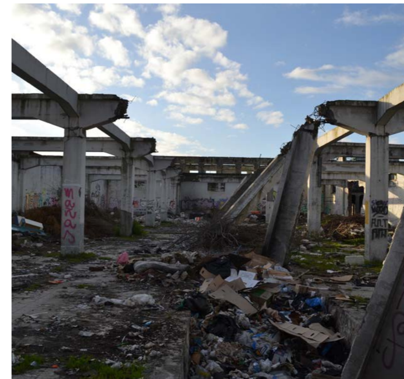
(fig.36) Restos Ex - Fábrica de Paños Bio Bio ED02
