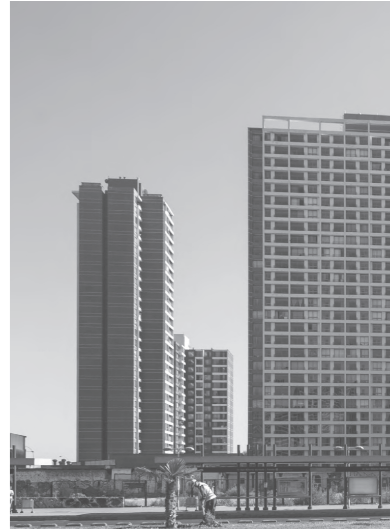
Estación Central, Santiago Fuente: Cristian Valenzuela, ARQ 98.
