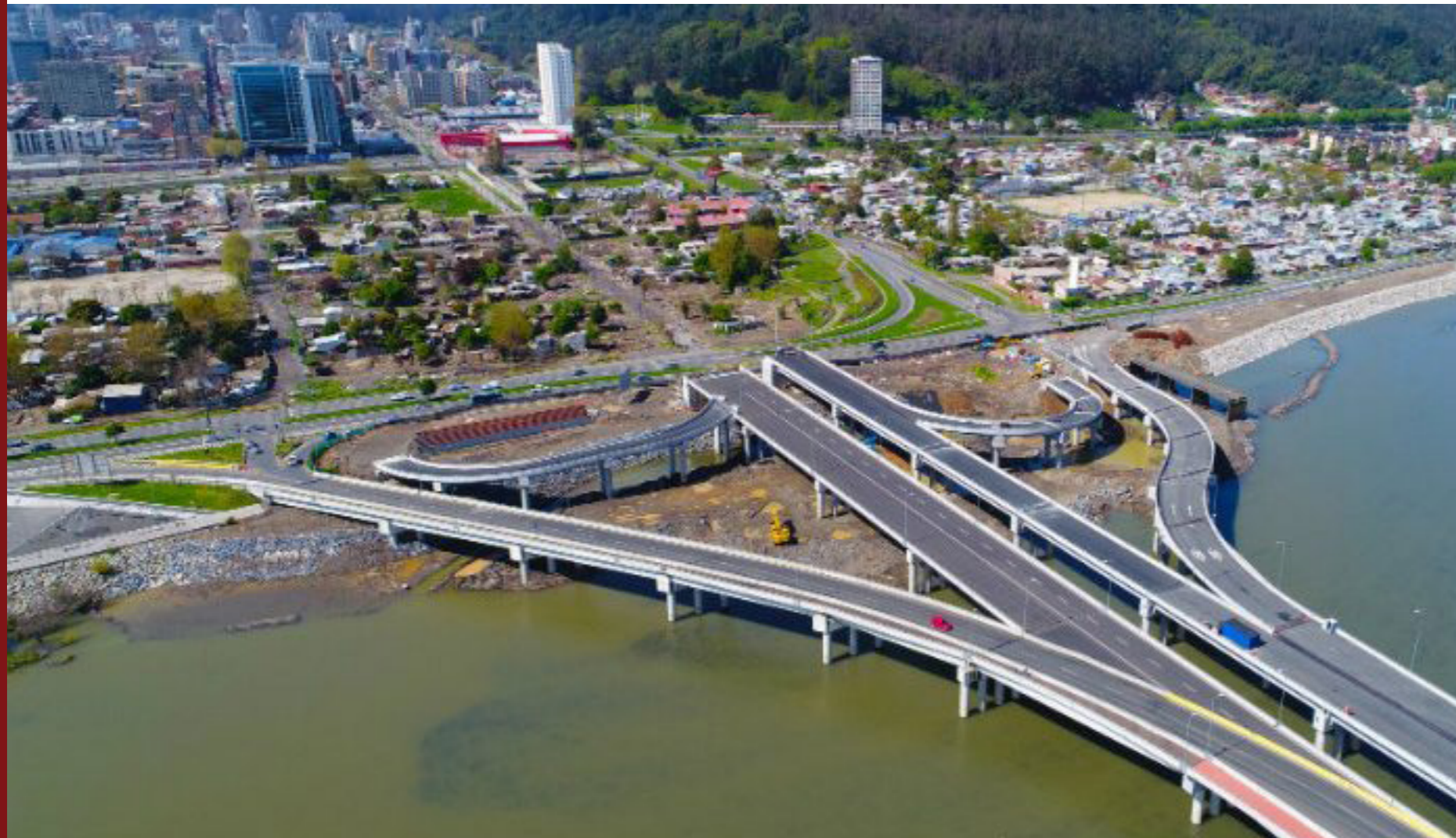
FIGURA 7 Puente Chacabuco en construcción 2018 fuente: Diario Concepción
