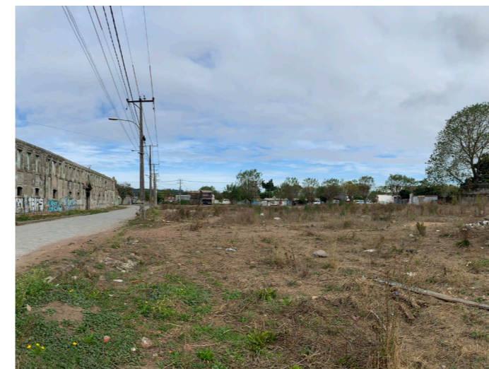
FIGURA 14 Sitio norte demolido fuente: Elaboración propia
