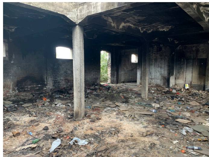
FIGURA 18 Interior primer nivel bloque sur fuente: Elaboración propia
