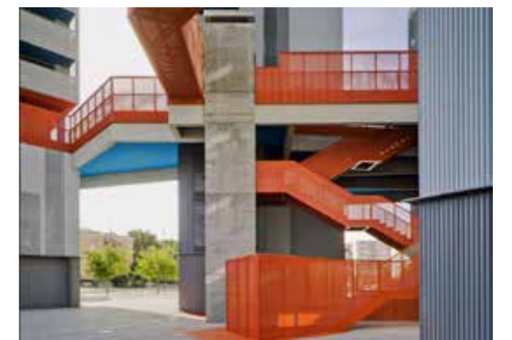
(J) Puente peatonal
