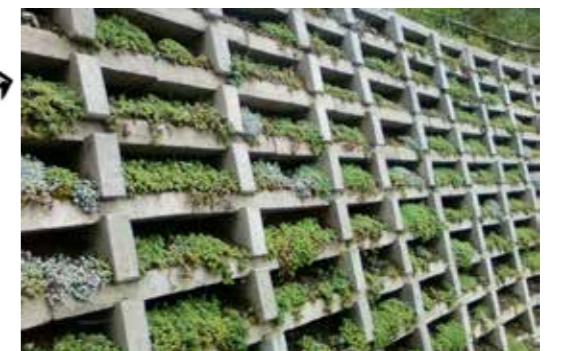
(K) Muro de contención
