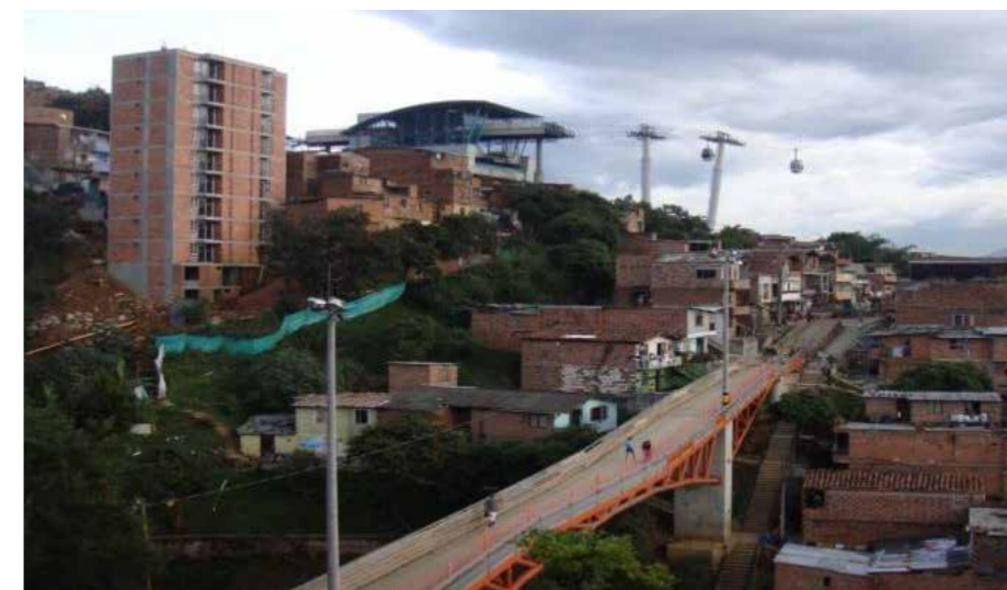
_Solución de vivienda y conectividad, asociadas a la puesta en marcha del Metro cable en sector PUI Nororiental Santo Domingo Savio, Línea K.
