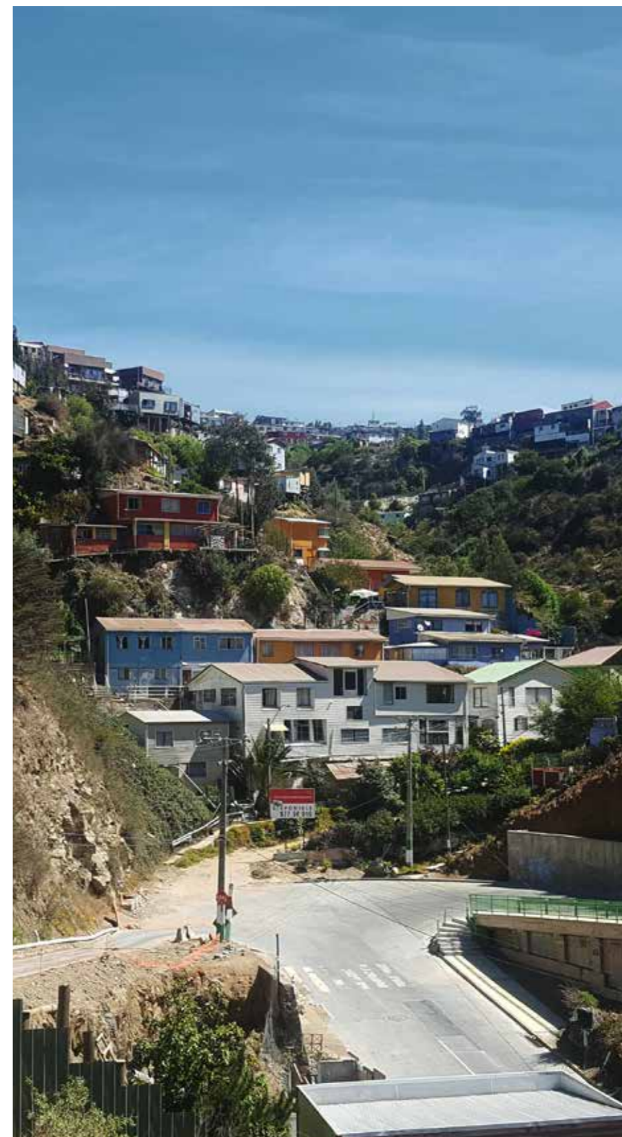
_Intersección Av. Alemania con Av. Francia /Elaboración propia
