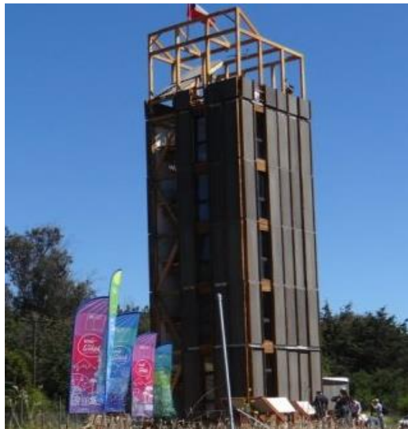
Ilustración 7, edificio experimental Peñuelas. Extraído desde www.madera21.cl
