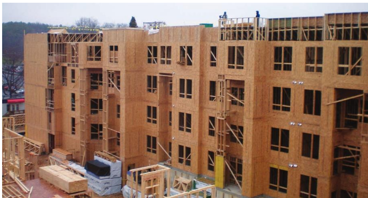
Ilustración 13, construcción de un edificio en Anaheim, USA, en sistema wood-frame
