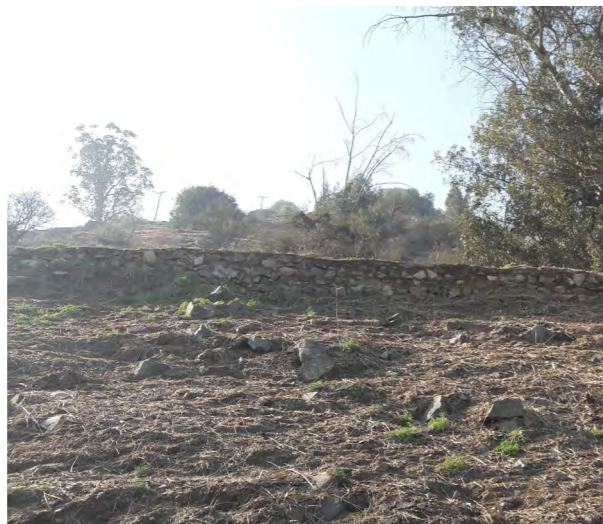
Contenciones de pircas en cerro.
