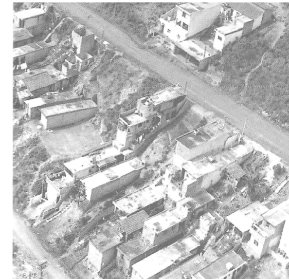
Subdivisión en ladera, parcialmente ocupada, presentando numerosas pendientes sin protección y expuesta a la inestabilidad (1981). Farah, F. (2003)
