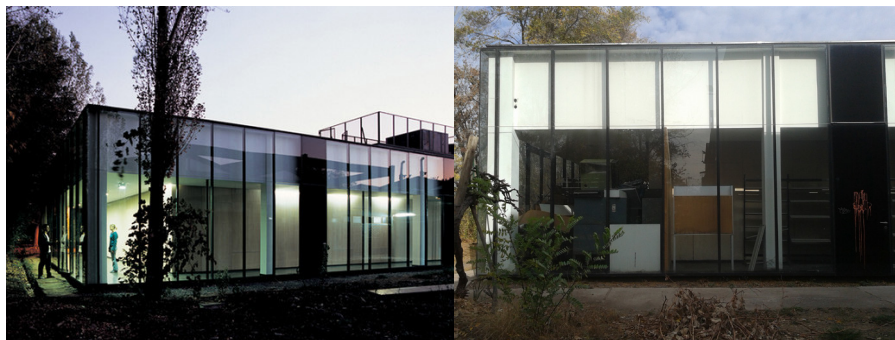
Figura 50: vista elegante parte trasera auditorio. Fuente: Plataforma Arquitectura, fotografía de Nicolás Rupcich. Figura 51: estado actual sector trasero del auditorio. Fuente: elaboración propia.
