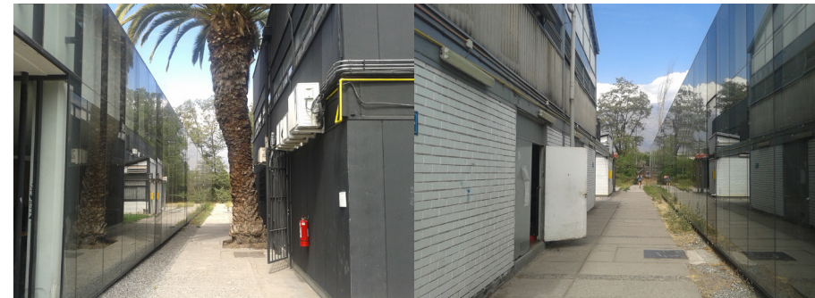
Figuras 54 y 55: pasillos exteriores laterales del auditorio. Fuente: elaboración propia.
