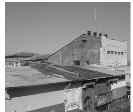
Figura 80. Vista de la estructura del teatro, en el año 2006, previo al proyecto de habilitación y Restauración.
