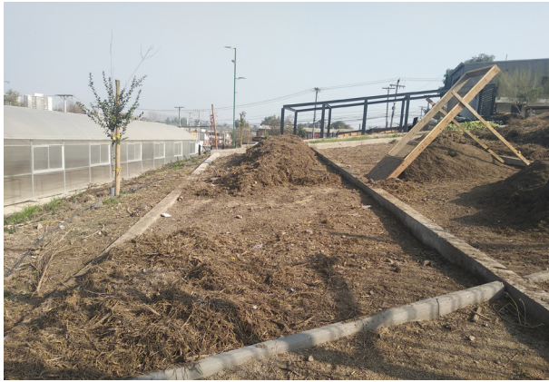
Imagen 33_ Cama de compostaje y a la derecha malla de tamizado (Elaboración Propia)
