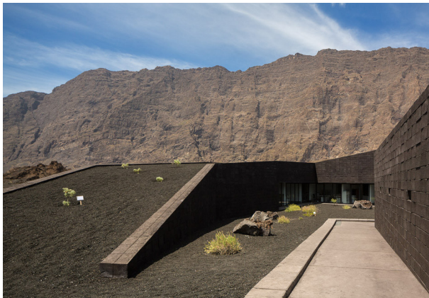
Imagen 109_ Oficina central Parque natural Fogo, Cabo Verde. ©Fernando Guerra | FG + SG (OTO). Fuente: www.plataformaarquitectura.cl
