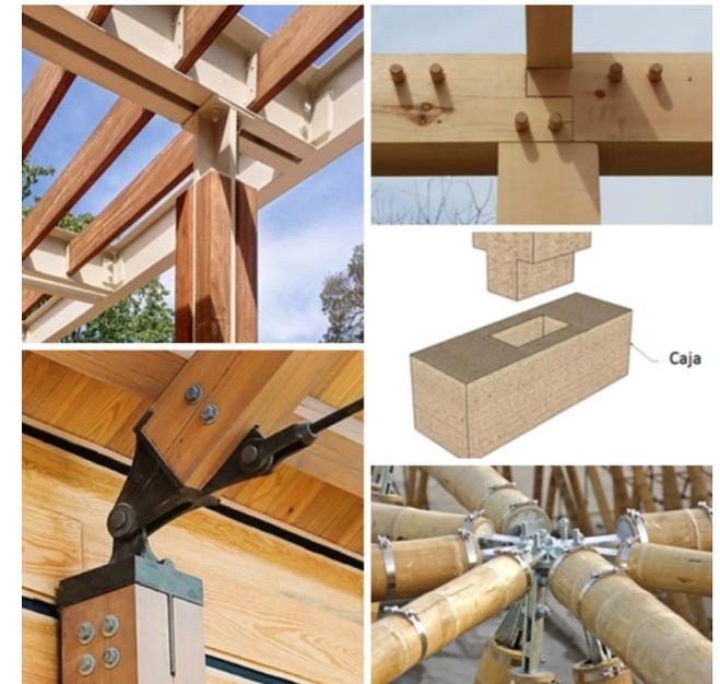
Tipos de Uniones en Construcciones en Madera. Fuente: <http://apuntesdearquitecturadigital.blogspot.com/2018/11/ensambles-y-empalmes-en-madera.html>
