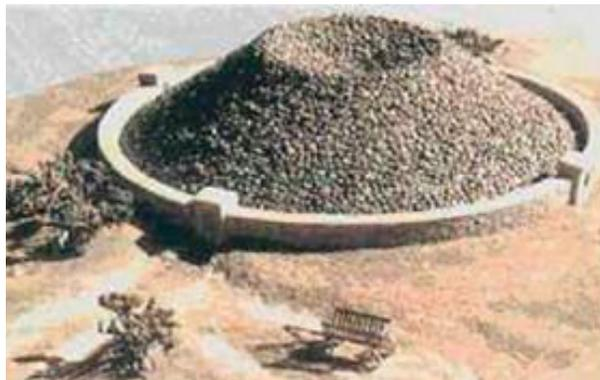
fig. 50: Colector de Zibold,
