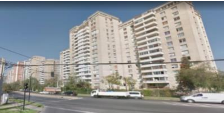
Edificio en zona Z-2 Fuente: Análisis de Alturas, Densidades y Constructibilidad. PCR-Ñuñoa.
