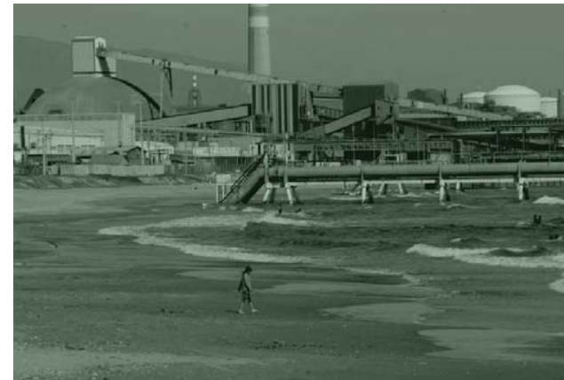
Fig.12 Termoeléctrica Ventanas Fuente: Michelle Carrere
