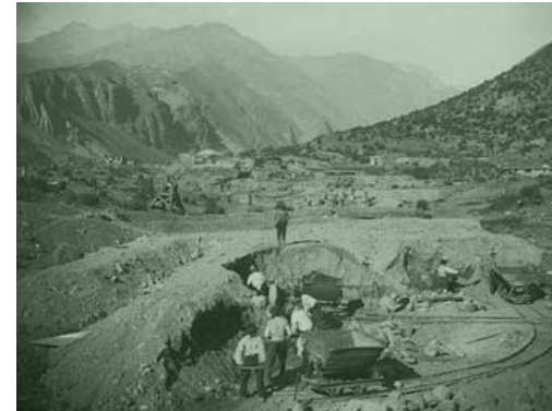
Fig.4 Central Maitenes, construcción de la bocatoma, 1923 Fuente: www.altomaipo.com
