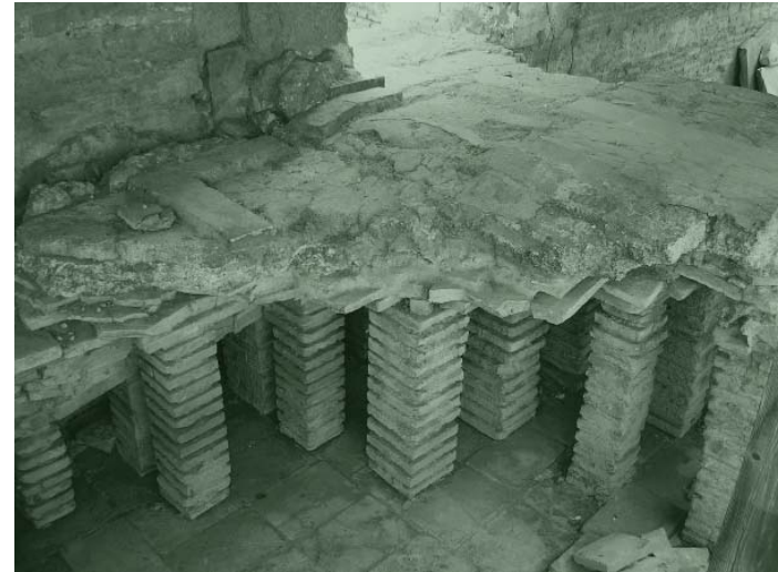
Fig.6 Estructura del hipocausto. Fuente: www.memo.fr
