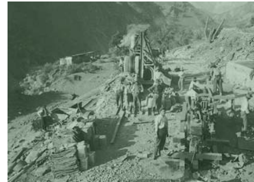
Fig.5 Central Queltehues, montaje de la turbina, 1928 Fuente: www.altomaipo.com
