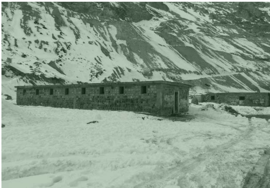
Fig.25 Edificaciones aledañas a Baños Colina Fuente: Elaboración propia
