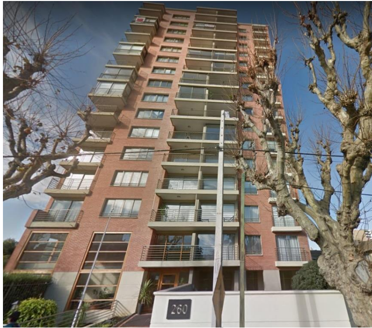
Figura 3.1: Vista frontal de Edificio Antígona por calle 5 Oriente (Fuente: Google Maps).
