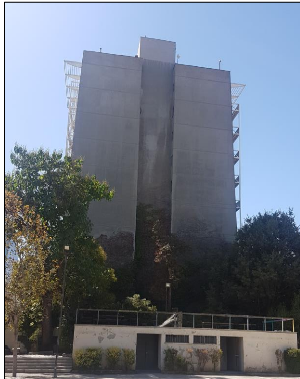
Figura 3.2: Torre Central, cara oeste.
