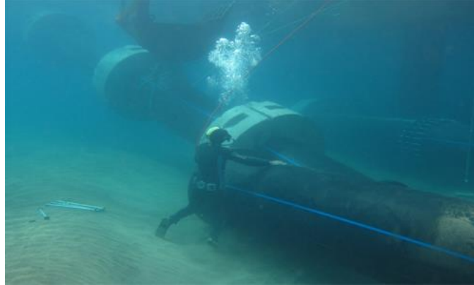
Figura 43: Fotografía de un emisario submarino descargando aguas servidas en el mar [84].
