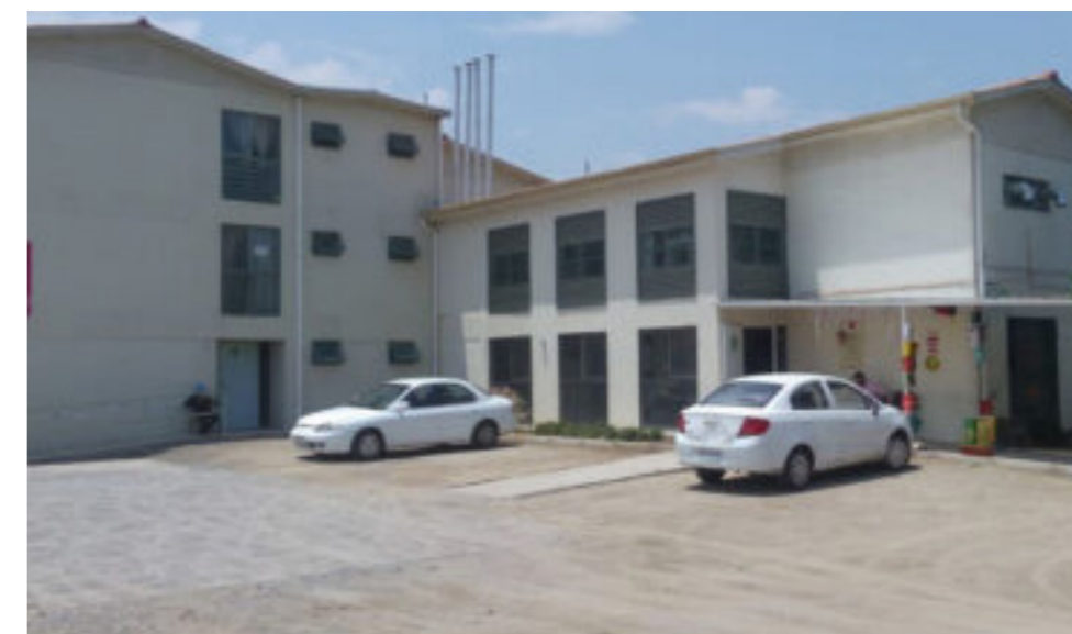
Imágen 8: Eleam Puente Alto. Fuente: somospuentealto.cl
