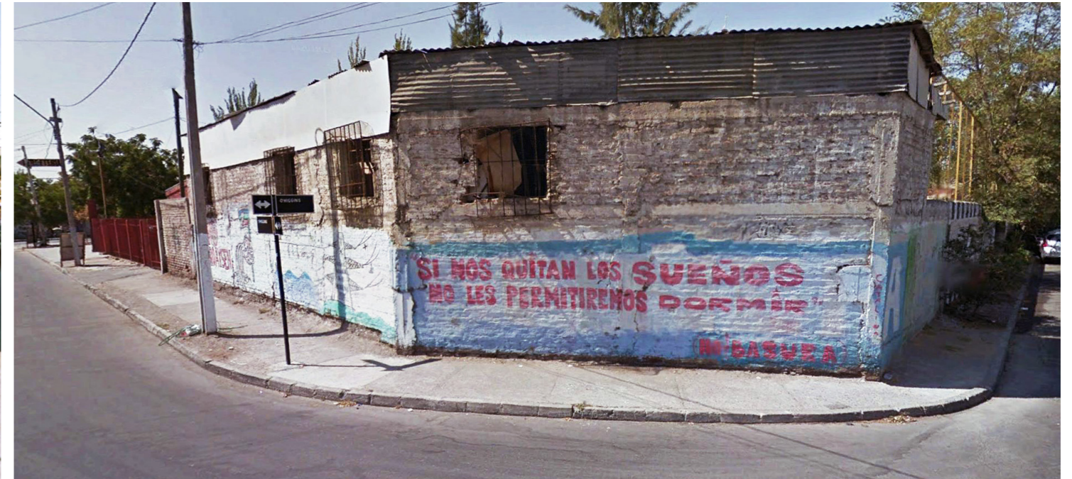
Imágen 17: Esquina NO del terreno.
