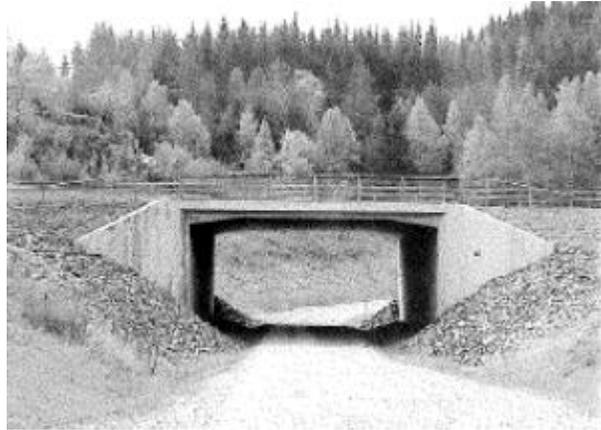
Figura 2.1: Puente losa de hormigón armado (Nedev, Khan, 2011)
