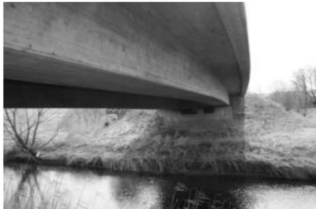
Figura 2.2: Puente de vigas de hormigón armado con losa de hormigón armado (Nedev, Khan, 2011)
