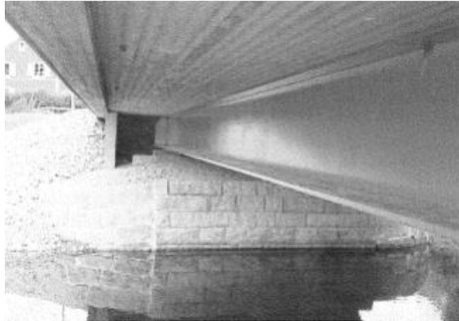
Figura 2.4: Puente de vigas de acero con losa de hormigón armado (Nedev, Khan, 2011).
