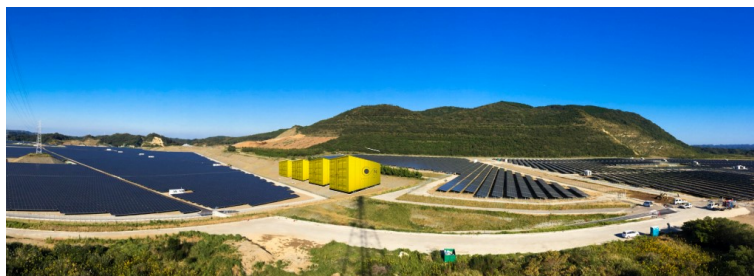
Figura 3.17: Baterías en generación.
