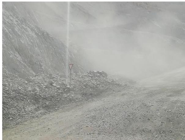
*Figura 40: Camino construido con material adecuado pero polvoriento.*
