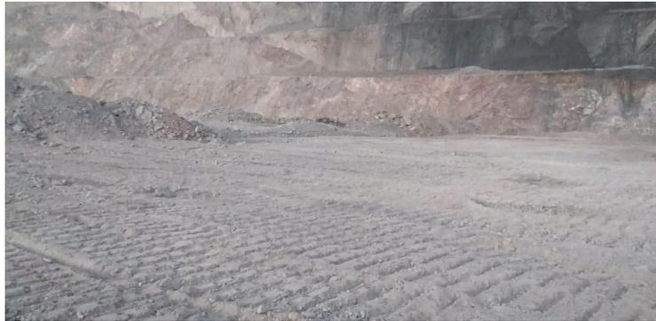
*Figura 37: Camino construido con material calamina / ondulaciones.*
