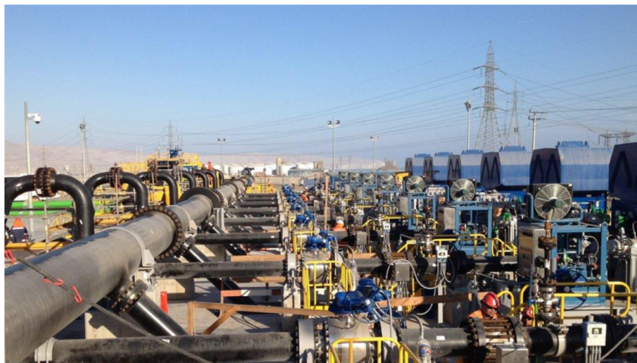
Figura 1.6: Instalaciones con cañerías de transporte de agua salada presentes en el norte del país. Fuente: Consejo Minero
