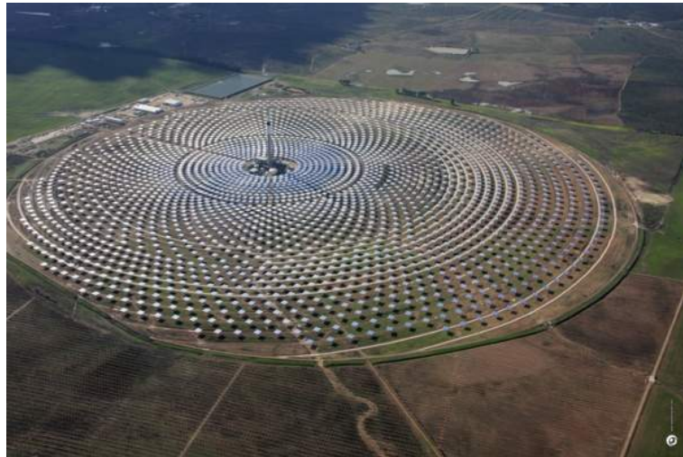
Figura 4.4: Vista de la Planta GEMASOLAR, propiedad de Torresol Energy . Sevilla, España
