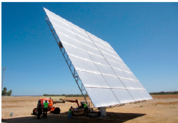
Figura 2.1: Helióstato de Cerro Dominador. Fuente: Grupo ACCIONA
