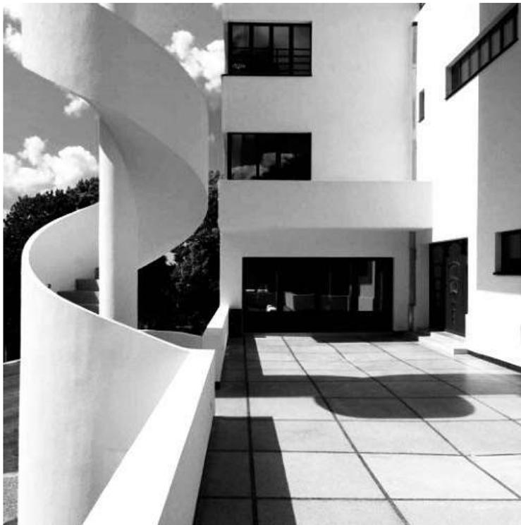
*Imagen 168. Detalle de la escalera de espiral construida en hormigón armado. Bélgica. (1932).*
