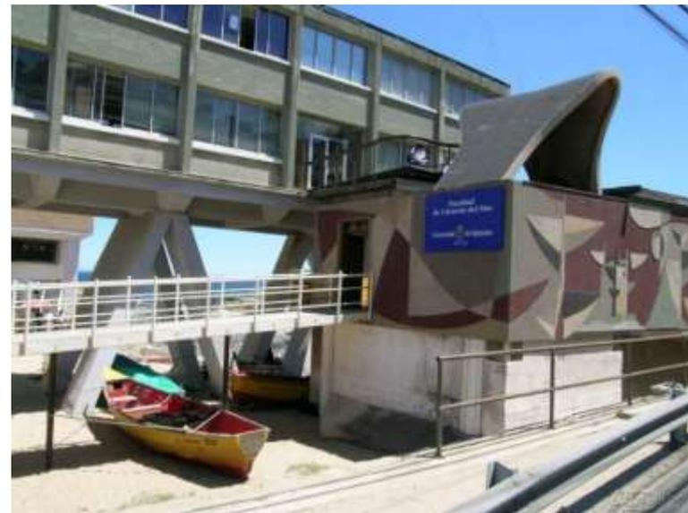
*Imagen 58. Vista del uso de rampas, y pilotes en diagonal, que permiten al edificio posarse sobre la playa. Reñaca. (2018).*
