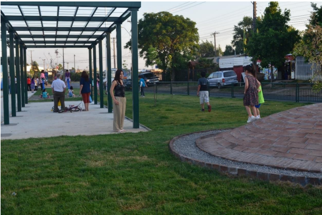
Imagen 3: Construcción Parque 17 norte – Territorio 5
