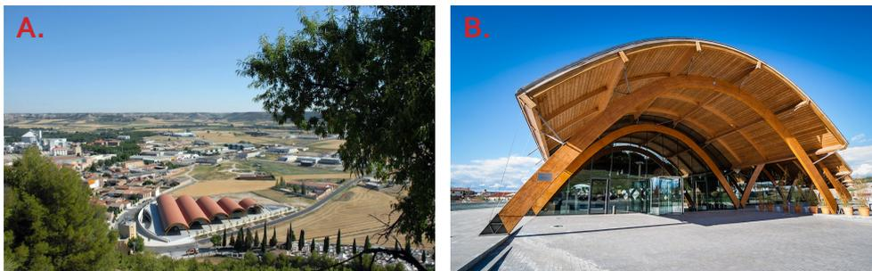
**Figura 25.** A. Vista Panorámica de Bodegas Protos. B. Fotografía apreciando arcos de madera laminada y costaneras de madera. (DK <protos>, 2018).
