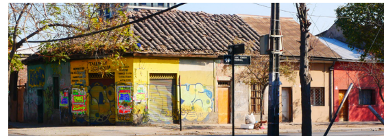
Fig 55: Vivienda en manzana aledaña con tejas de arcilla.
