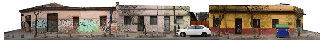
Fig 62.3: Fotografías Elevaciones calle Colón.
