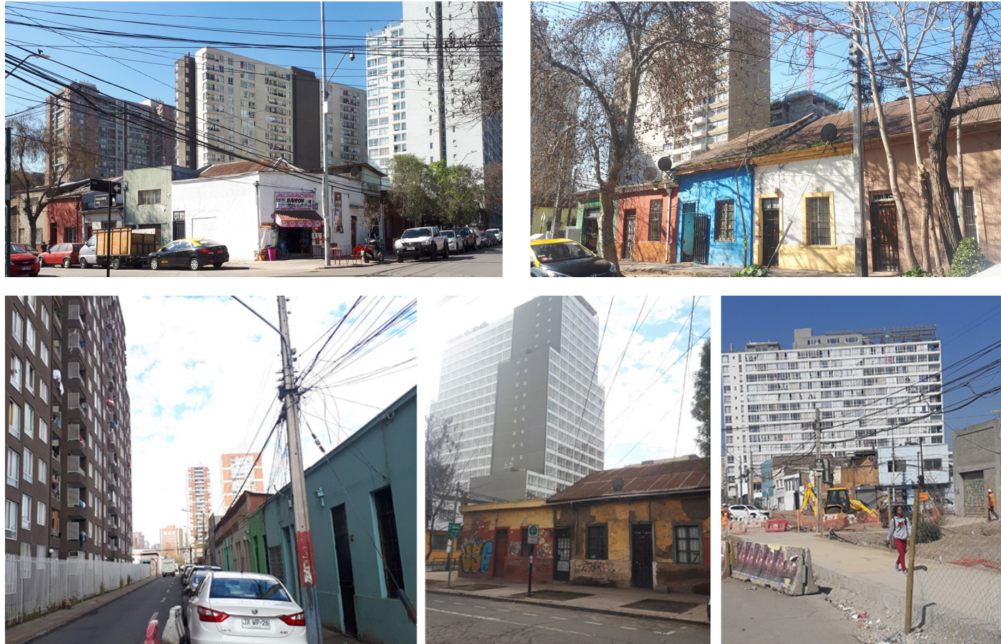
Fig. 13: Desarrollo Inmobiliario en altura en la Población Ovalle, Archivo Propio.
