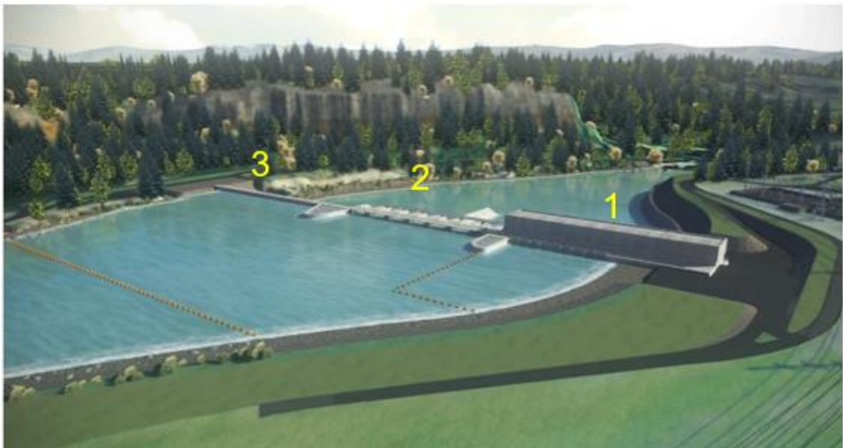
Figura 2.3 Esquema central hidroeléctrica Run of River. Proyecto Rucalhue, VIII Región Bio Bio
