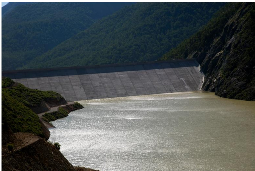
Figura 10: Embalse Ancoa finalizado Fuente: Página oficial de BESALCO, empresa contratista del embalse Ancoa
