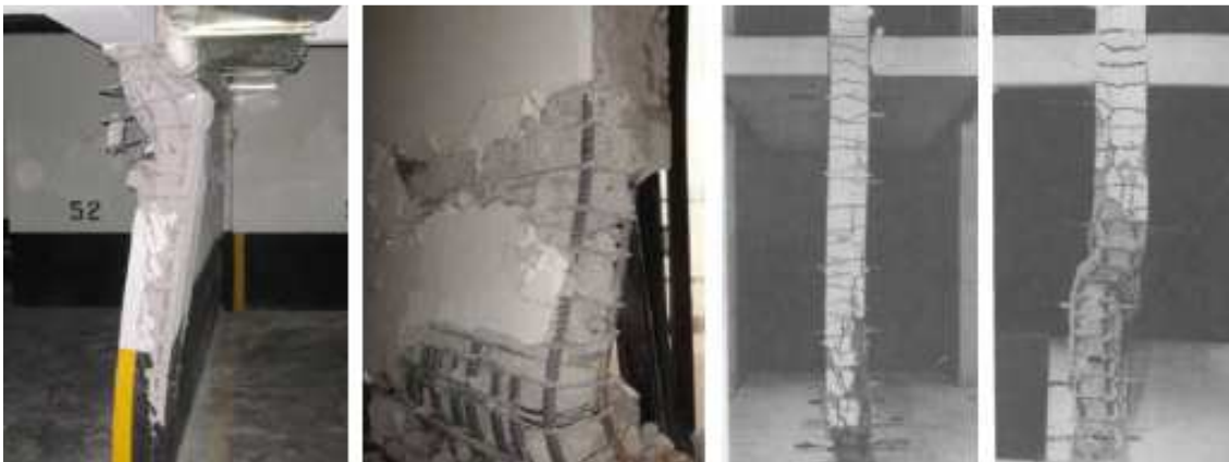
Figura 3: Ejemplos de pandeo global en muros [12].
