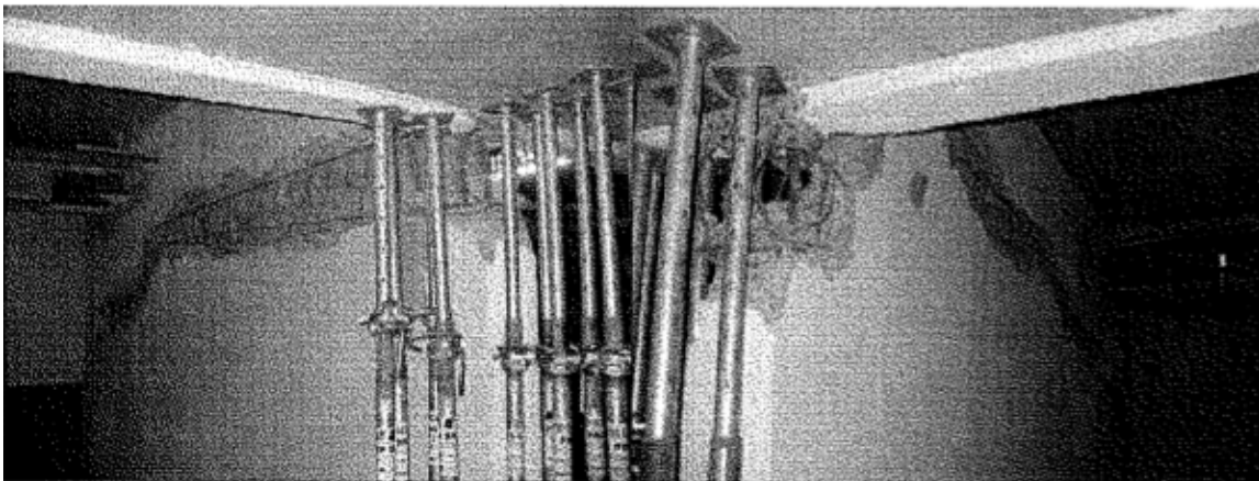
Figura 25: Muro eje F primer subterráneo torre I [15].
